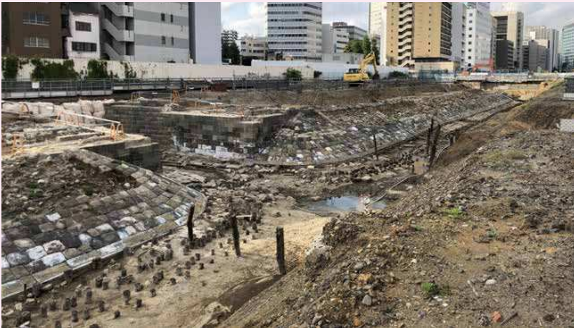
品川駅改良工事で発見された「高輪築堤跡」
