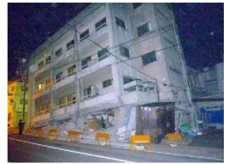
▲建物被害の状況
