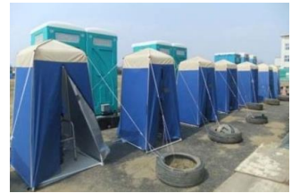
▲災害用トイレの設置
